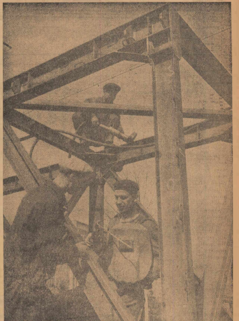
Colectivul uzinelor „1 Mai” din Ploiești, produce instalații de foraj mult apreciate de petroliști. În clădire: Sudorul Vasile Pircăbăb, lăcătușul Alexandru Filitiș și Vasile Turcan, lucrînd la substructura turlei de foraj a unei instalații 4 L.D.
