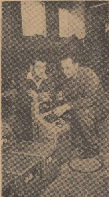
Aspect din secția montaj-ajustaj a întreprinderii „Electrotehnica” din Capitală. Frunzașii în producție Ion Tudorache și Petre Tunsu lucrează la montarea aparatului de sudat Vipelex
