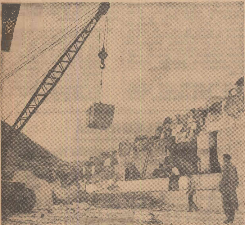
La Ruschița, în regiunea Banat, s-a dezvoltat în ultimii ani cea mai mare exploatare de marmură din țara noastră. Avînd calități naturale deosebite, marmura de Ruschița este folosită pe scară largă la înfrumusețarea noilor construcții. În clipșu: Aspect de la un front de exploatare a marmurei. Foto: AGERPRES
