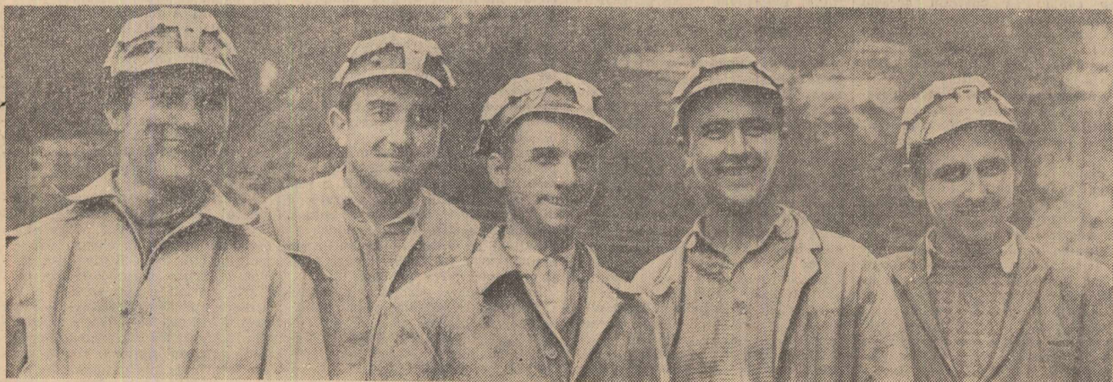
Minerul fruntaș din brigada condusă de Ion Irimuș de pe șantierul hidrocentral „16 Februarie” de pe Valea Argeșului. De la stînga la dreapta: Traian Irimuș, Valer Pocol, Ion Irimuș, Ion Hosu și Ion Pocol
