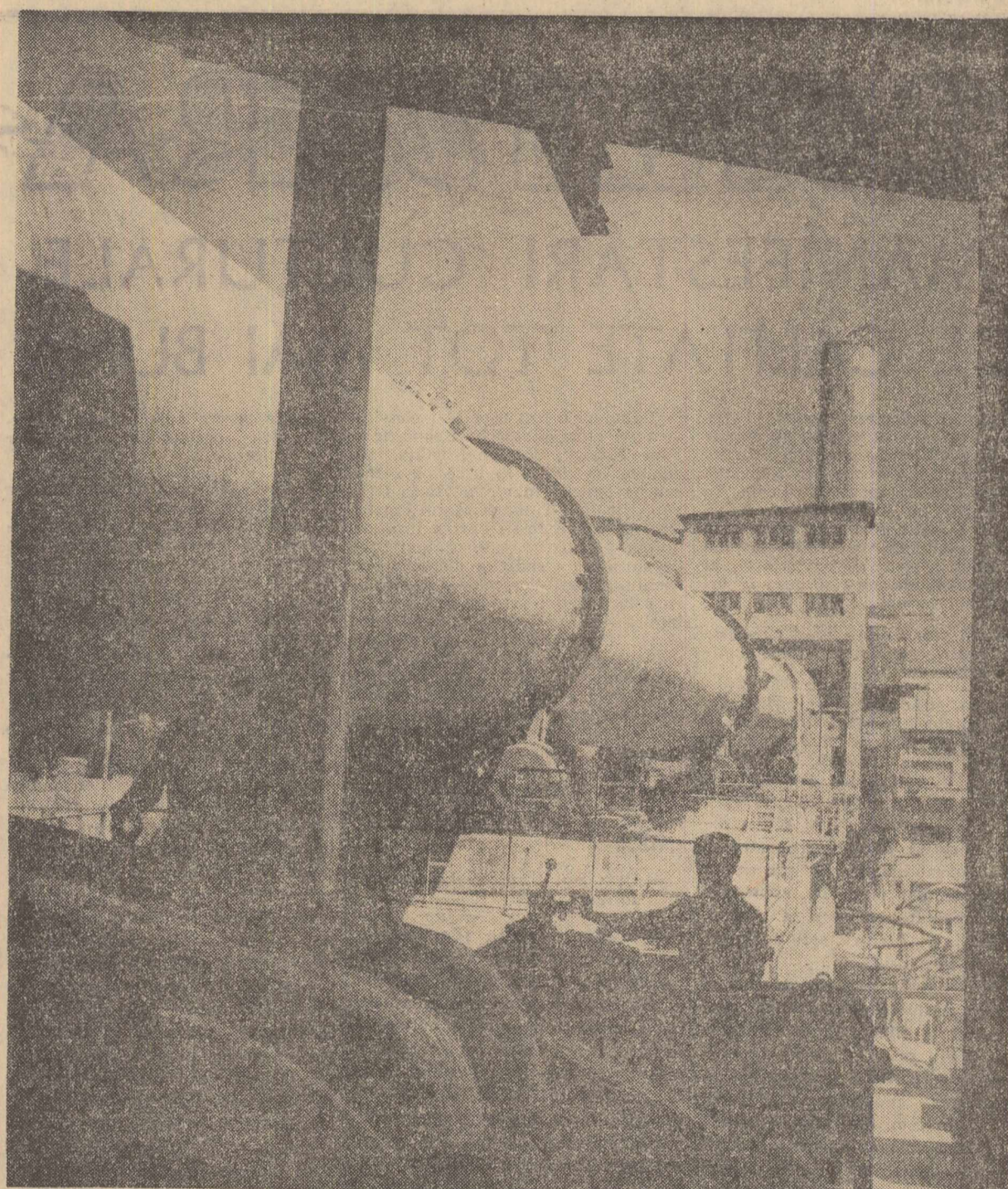
Întă noul cuplor de la Fabrica de ciment din Fieni ce a intrat anul acesta în funcțiune și care are o capacitate de 800 tone de clincher pe zi. Aceasta reprezintă o treime din întreaga producție a fabricii. El este primul din seria marilor cuploare ce urmează să fie construite. Avînd o lungime de 150 m., noul cuplor este prevăzut cu un înalt grad de automatizare. Foto: AGERPRES
