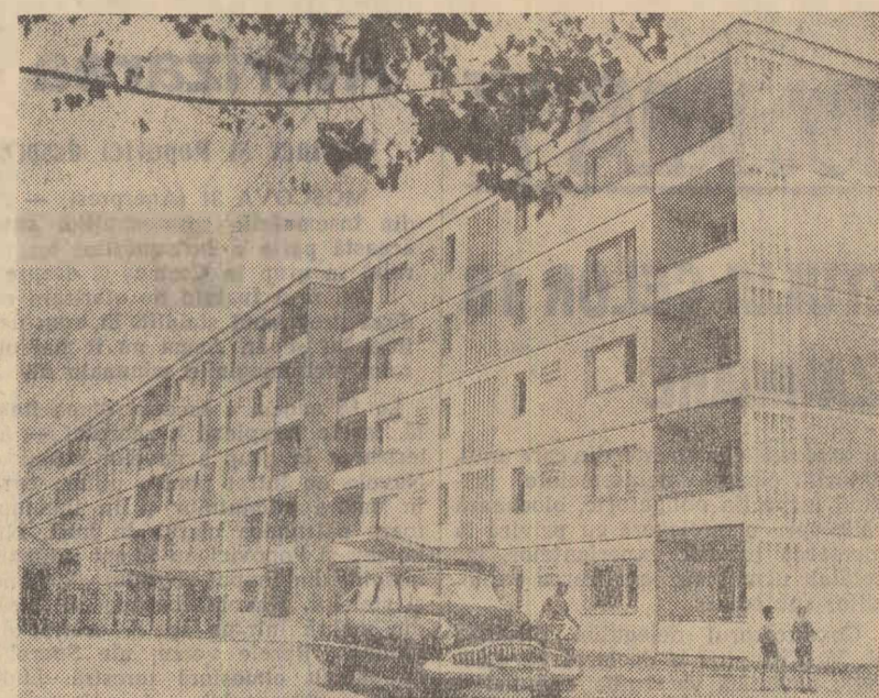
În noile blocuri de pe strada Primăverii din cartierul Ieșean Socola, au fost date recent în folosință primele 80 apartamente.
