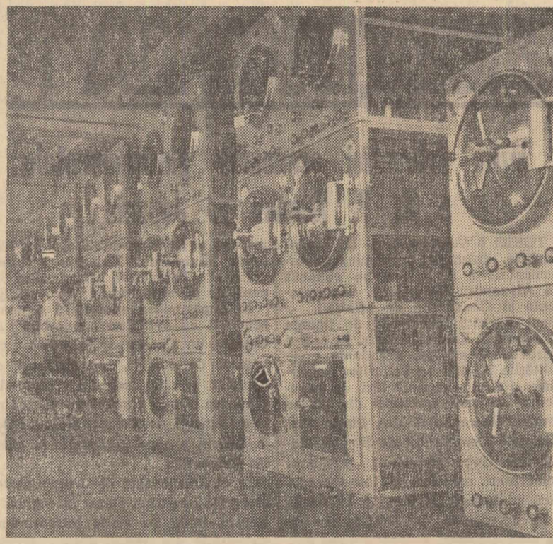
În secția instalațiilor de la Industria tehnică medicală din București, un nou lot de instalații de sterilizare este gata pentru a fi expediat unităților sanitare. În clădire: Tovarășul Vasile Preja execută ultimele verificări înainte de expediția instalațiilor.
