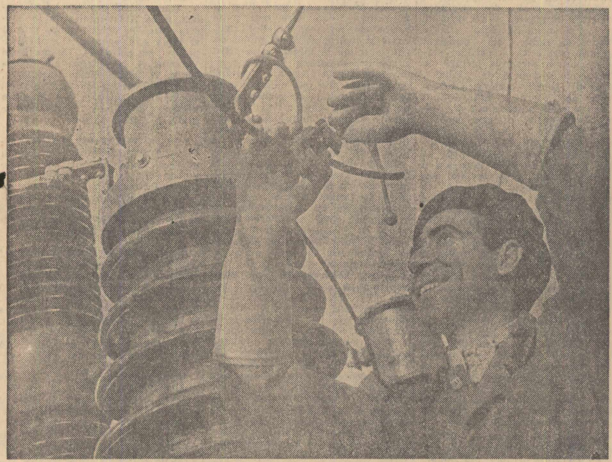
Colectivul de muncă al stației electrice Tîlcan din Capitală se străduiește să întretină în condiții cât mai bune aparatura cu care aceasta este dotată. În clipă: Electricianul principal Dragoș Petrescu executând o lucrare de protecție a instalației
