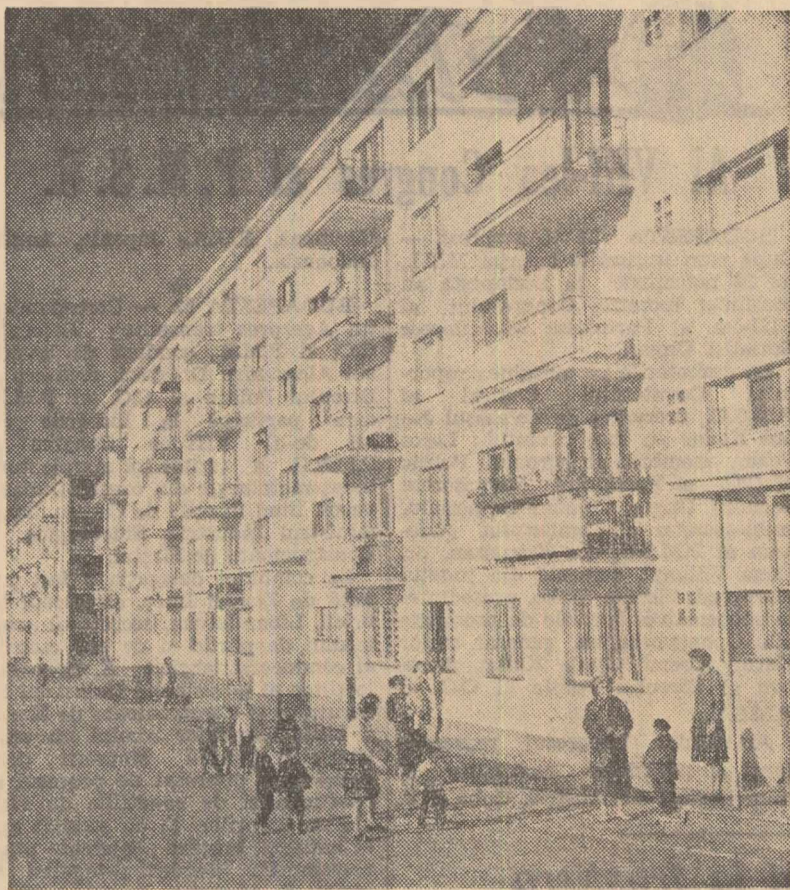
La intrarea în orașul Brașov, pe partea stângă a șoselei naționale a răsărit de curind un „bucet” de blocuri noi, pastele colorate, pe care constructorii le-au boțezat „Steagul roșu” — IV. În clișeu: Vedere parțială a noului cartier brașovean
