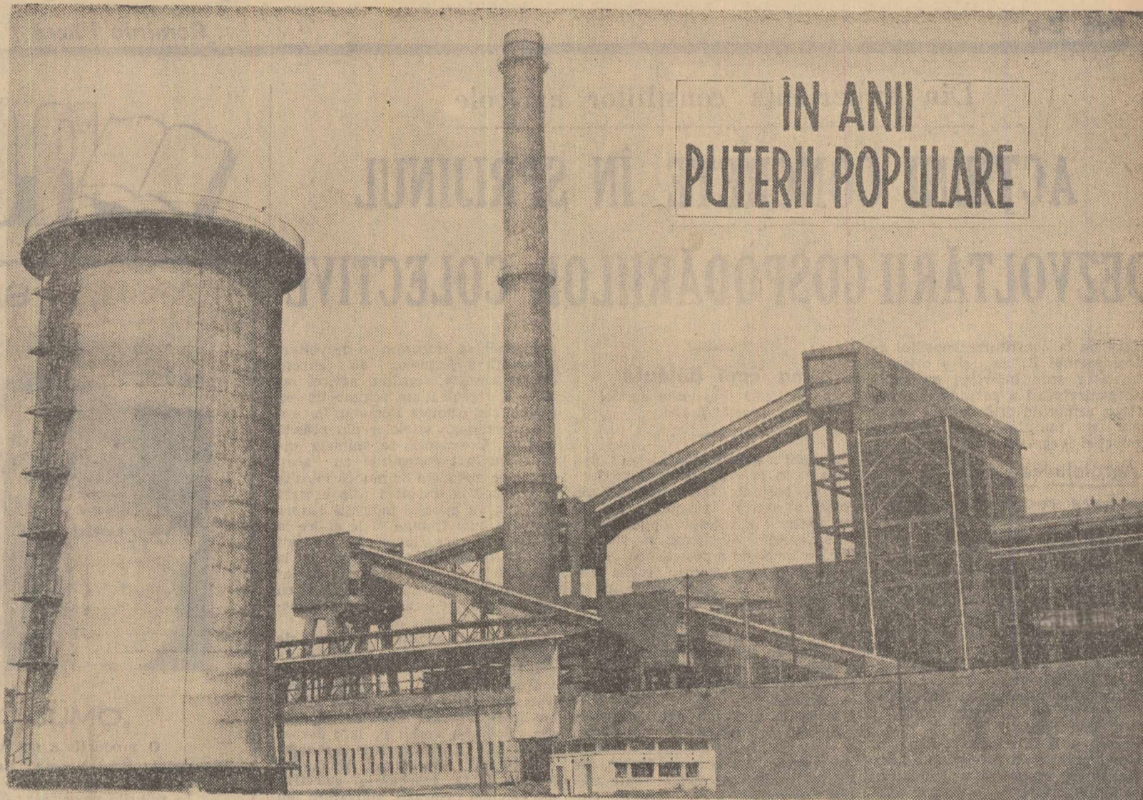
Vedere parțială a aglomeratorului de minereu, una dintre noile construcții reșinene
