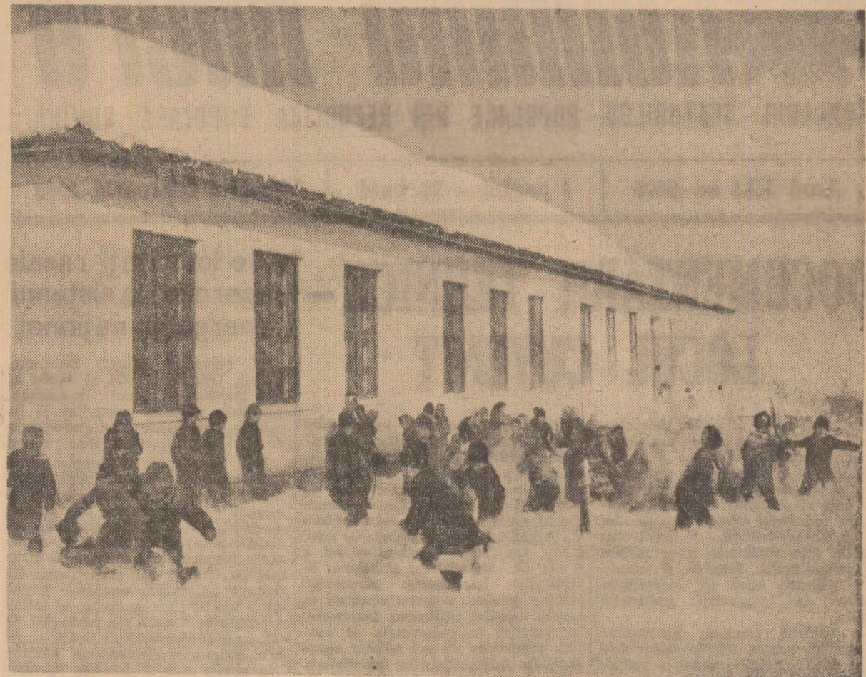
Anul trecut a fost dat în folosință o școală nouă de 8 ani în comuna Popricani, raionul Iași. Noul local de școală a fost construit de statul popular cu ajutorul cetățenilor din comună. În clădire: în reșeație, elevii clasei a V-a fac „o încălzire” prin zăpada proaspătă căzută.
