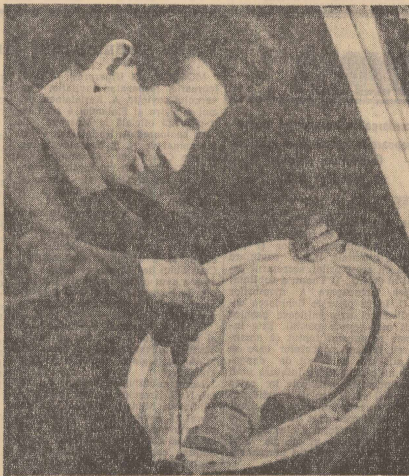
Un aspect din secția montaj corpuri de iluminat de la întreprinderea metalurgică „Precizia” din Capitală. Ion Rădulescu lucrează la montarea unor corpuri de iluminat cu vapori de mercur
