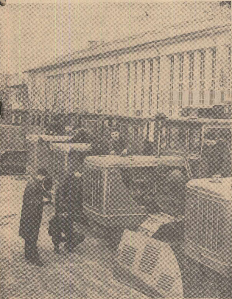
La întreprinderea pentru exploatarea utilajului greu din Capitală, se face o ultimă revizie a unui lot de tractoare care urmează să fie expediat pe unul din șantierelor de îmbunătățiri funciare.
