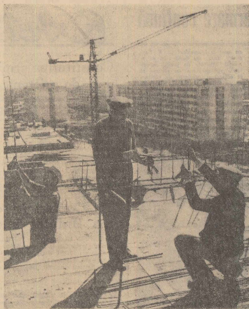
Fierari-betonisti din echipa lui D. Șerban lucrează la planșul etajului VII al blocului nr. 11 de pe șoseaua Giurgiului din Capitală
