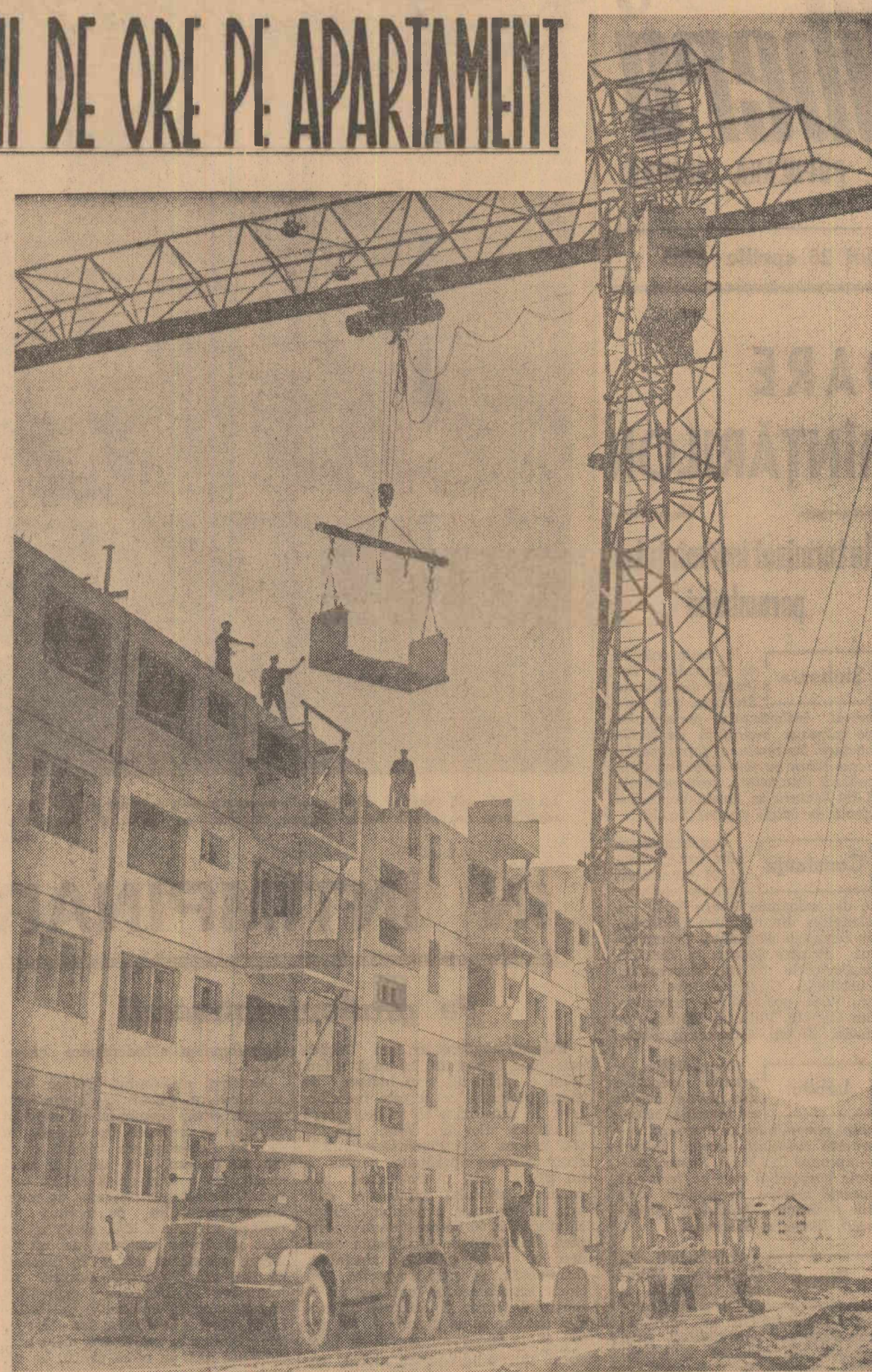
Pe șantierul „Steagul Roșu” macaraua portal ridică un balcon prefabricat.
