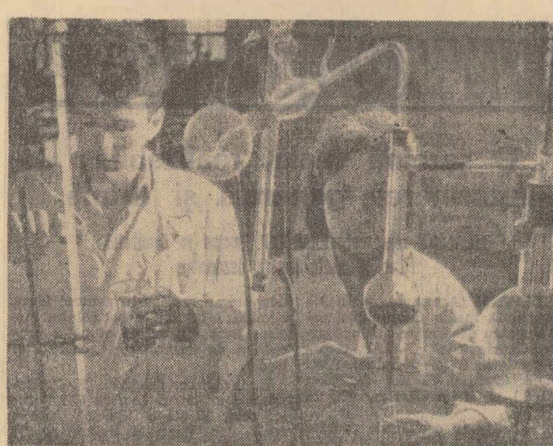
În laboratorul de pielărie al Facultății de Chimie Industrială a Institutului Politehnic din Iași, studenții Pompei Gruiță și Victoria Păuneanu din anul IV, fac o determinare a conținutului de azot din piele.
