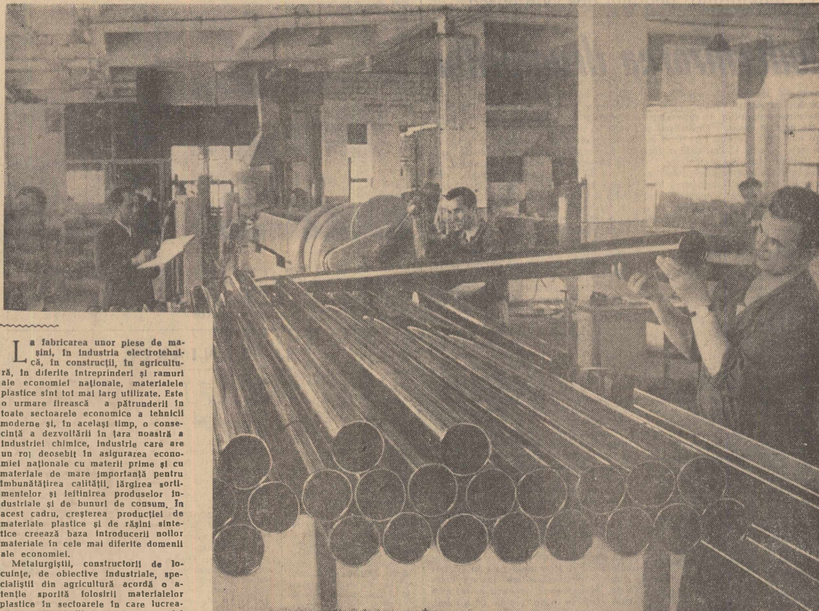
Zilnic alte cantități de țevi din polietilenă de vinil sînt expediate de la Fabrica de mase plastice București. O parte din ele sînt destinate lucrărilor de construcții și de hidroameliorații. În clădire: Un aspect din atelierul unde se confecționează țevile cu un diametru de 110 milimetri
