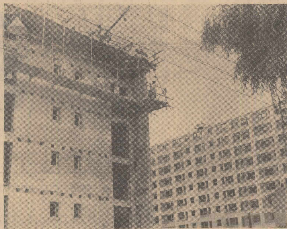
Alături de blocul P. 4 la care glisarea a fost terminată se ridică vertiginos blocul P. 5 Foto: NICU VASILE
