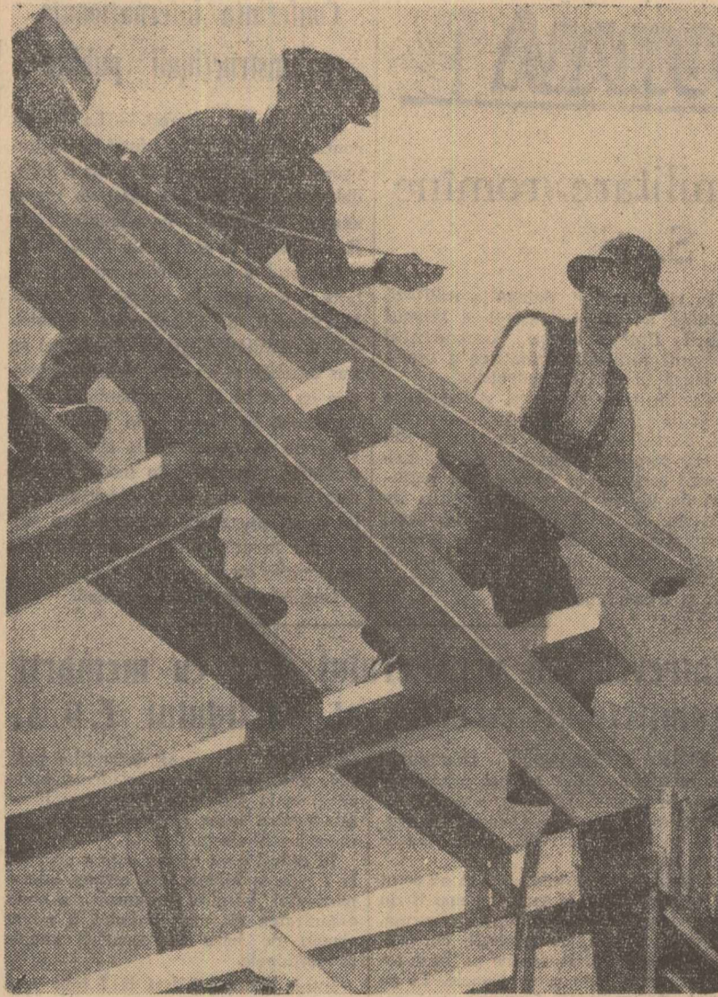
Colectivisții din comuna Ciorogirla, regiunea București, au ajuns cu lucrările de construcție a unui adăpost pentru animale, la acoperiș. Ei se străduiesc ca lucrarea să fie terminată cit mai repede.
