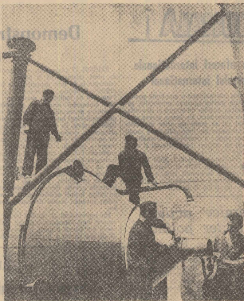
Colectivul de muncă de la atelierele 9 Mai din Capitală se străduiește să îmbunătățească tot mai mult caracteristicile tehnice ale produselor. Aici se fabrică piese de schimb și utilaje pentru fabricile ce produc materiale de construcții. În clădire: Echipa de lăcătușimontori condusă de Constantin Cucu făcînd ultimele verificări la suportii de susținere ai silozurilor pentru ciment.
