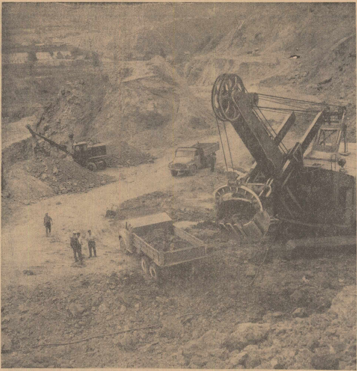
La exploatarea minieră Telluc există pe lîngă sectorul subteran și un sector de exploatare a minereului la suprafață în carieră. Aici munca se face aproape în întregime cu mijloace mecanizate. Fotografia noastă vă redă un aspect de la exploatarea minereului de fier în carieră. Foto: AGERPRES
