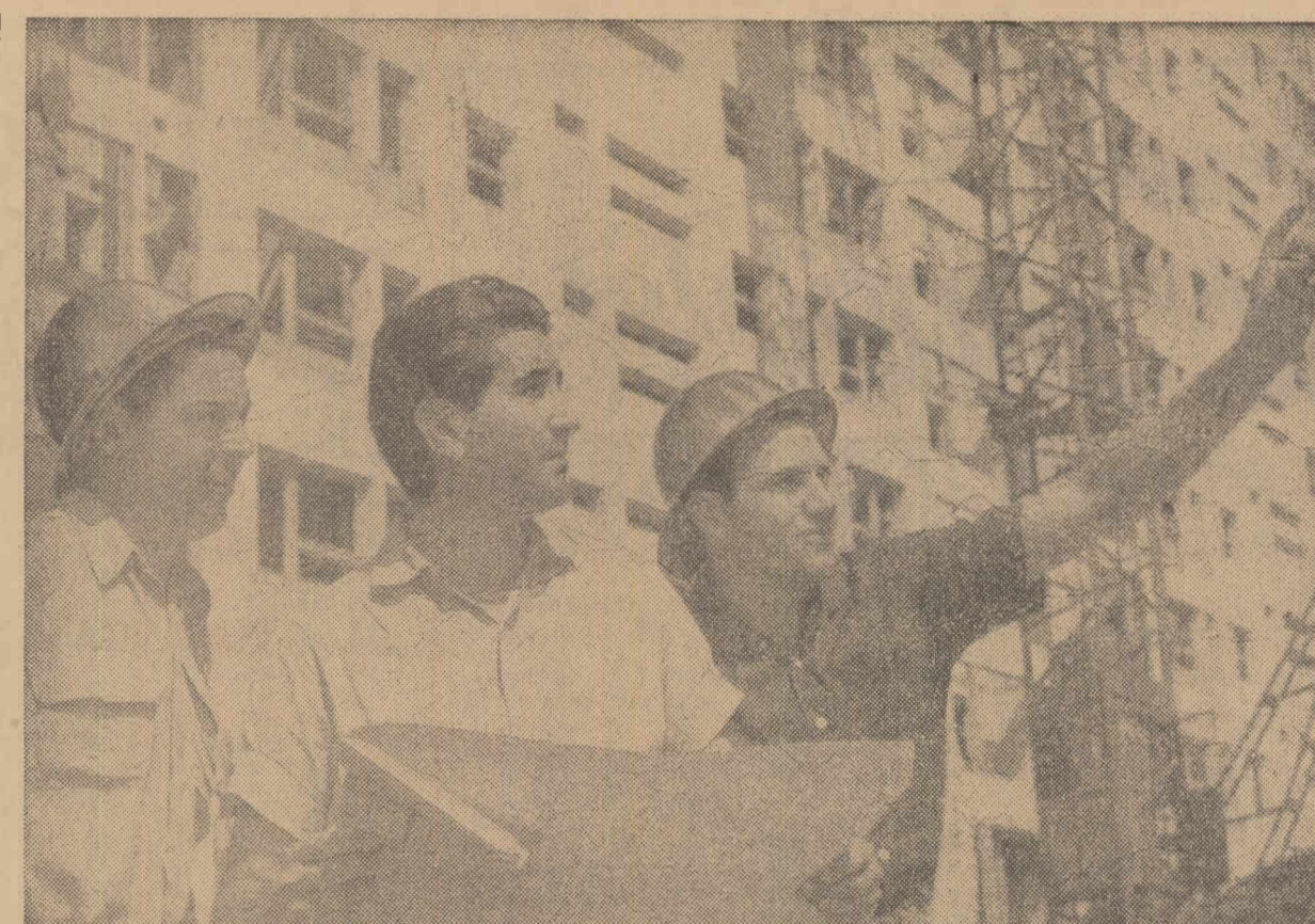
O imagine de pe șantierul de locuințe nr. 2 din București, Șoseaua Mihal Bravu — Christigii, unde s-au construit mai multe blocuri folosindu-se cofrajele gilsante. Maistrul Ion Nită și dulgherul Ion Neamtu și Alexandru Csavar, pe care îi vedeți în clipse, sînt evidențiați în întrecere pentru rezultatele dobîndite în muncă.
