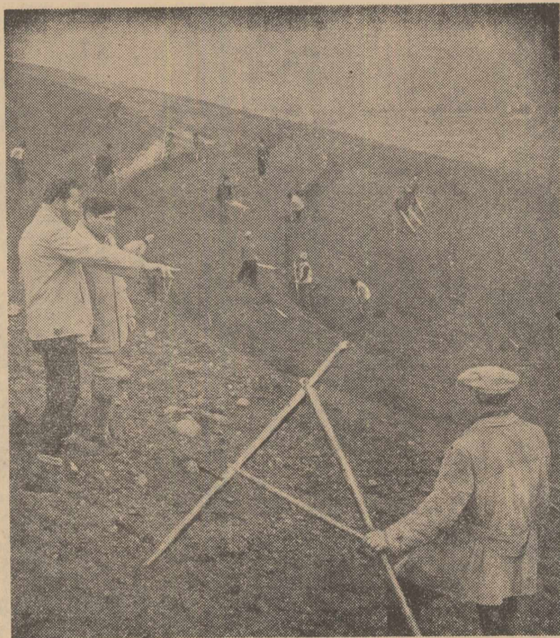
Pentru ca terenurile neproductive sau slab productive să fie puse în valoare, se extinde tot mai mult metoda de terasare în vederea plantării viței de vie și a pomilor fructiferi. În clipă: Aspect de la lucrările de terasare care se execută la gospodăria de stat din Alba Iulia
