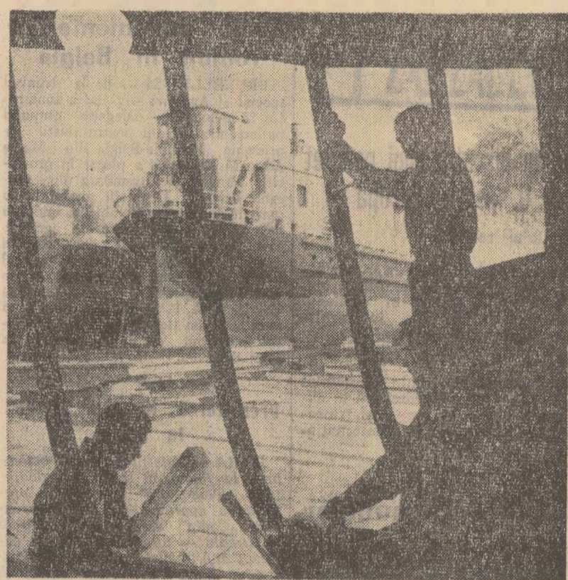
La Șantierul naval din Giurgiu, pe lângă reparațiile de nave se construiesc și agregate de malaxat bitum asfaltat. În clisue: brigada de montori condusă de Ion Pleșanu confecționează un asemenea malaxor
