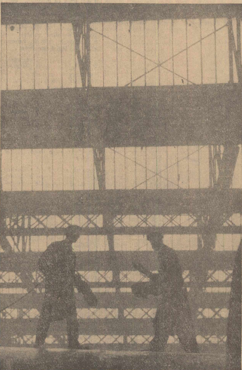
În secția de montaj utilaj chimic a uzinelor „Grivița Roșie” din Capitală Foto: AGERPRES
