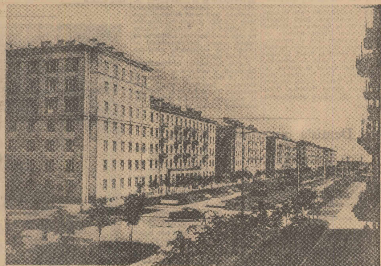
Și la Leningrad construcțiile de locuințe înainteză în ritm susținut. În clișeu: strada Altai, una din cele mai noi artere ale orașului
