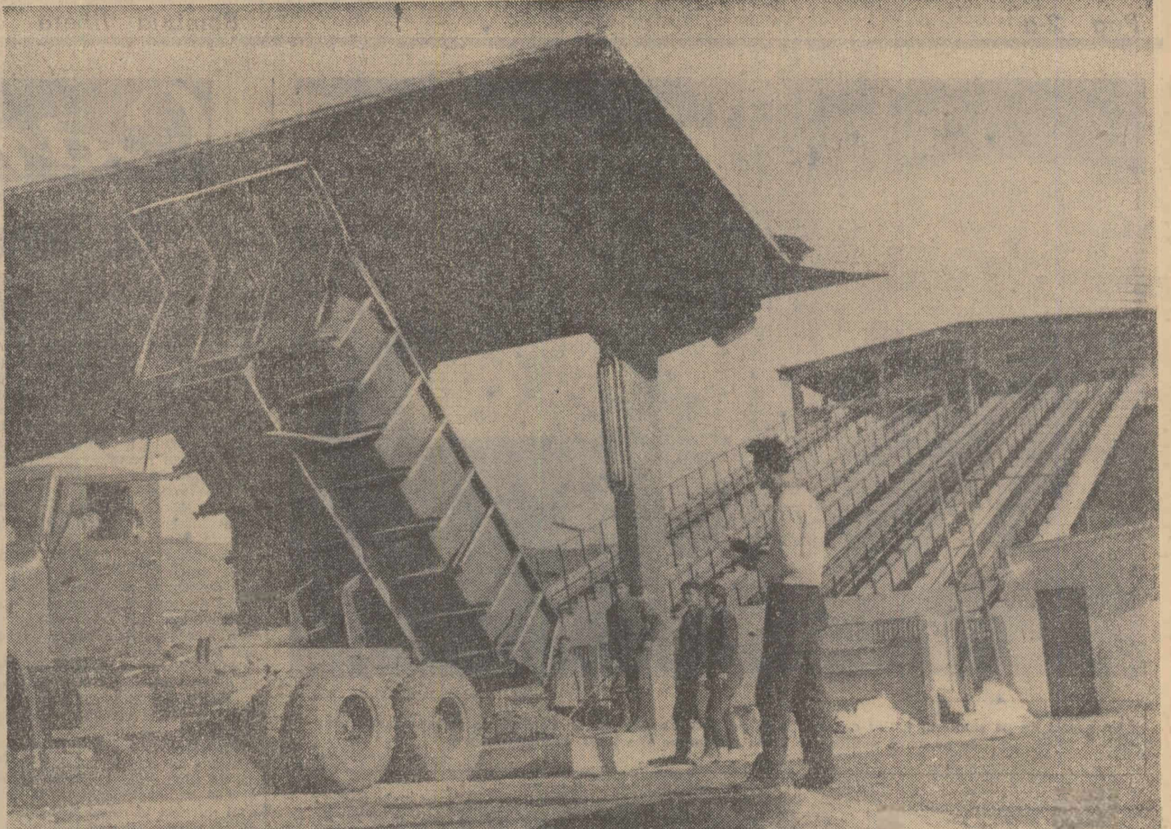
Uzina centrală de preparare a minereurilor din Baia Mare a fost ridicată în mai puțin de un an și jumătate. Ea are rolul de a flota minereul de la exploatarea minieră din împrejurimi și de a-l transforma — sub acțiunea agenților chimici — în concentrate metalifere care constituie materia primă a industriei chimico-metalurgice. În dreapta: Un aspect de la descărcarea minereurilor sosite de la exploatarea în uzina centrală de preparare
