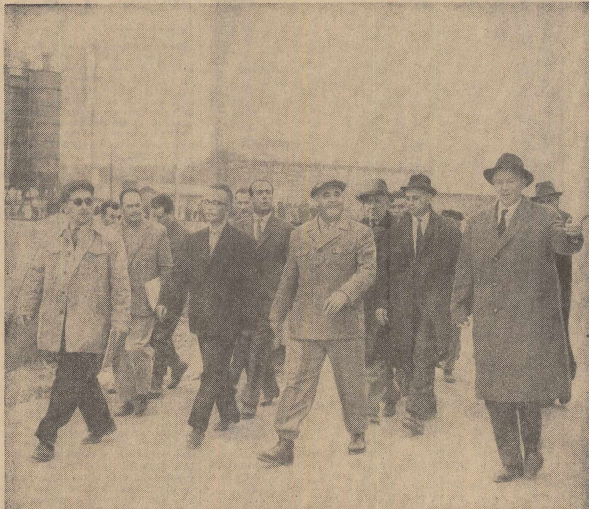
În timpul vizitării șantierului
