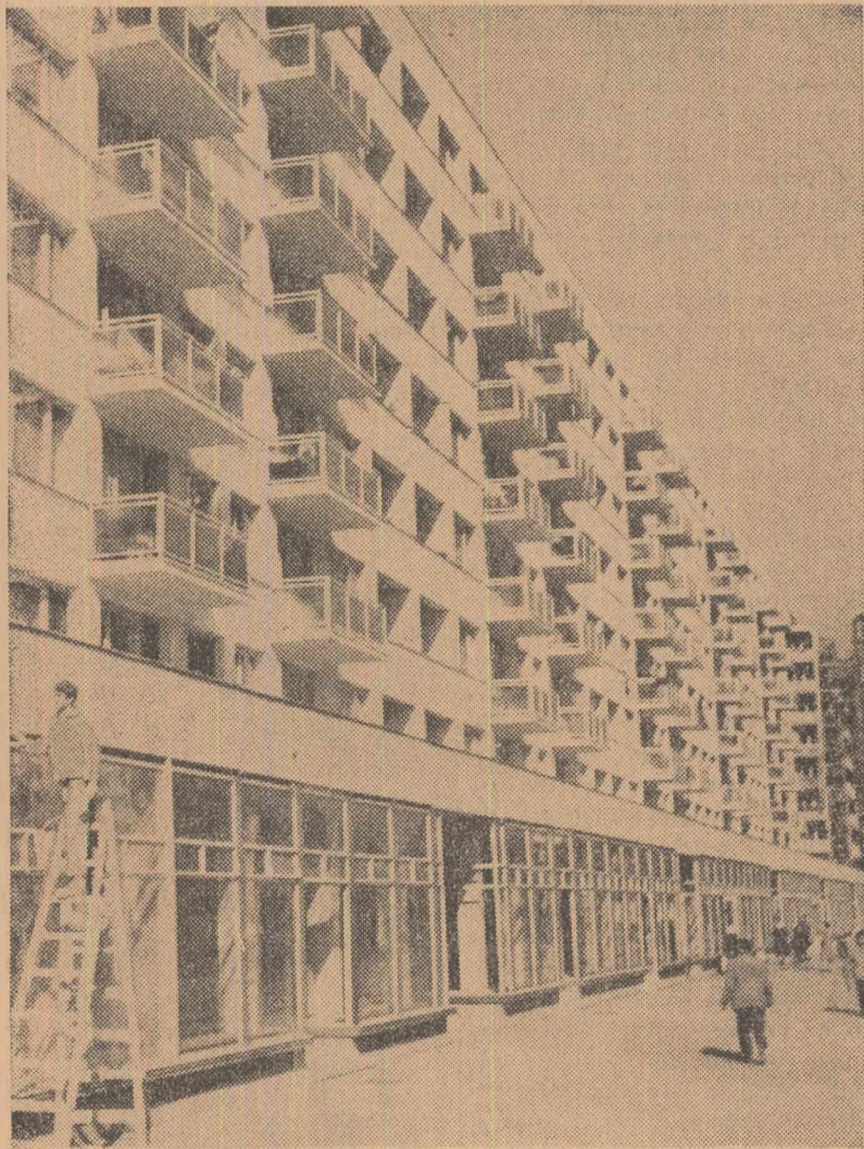
La noile blocuri de locuințe date recent în folosință pe șoseaua Giurgiului se lucrează la finisarea exterioară a magazinelor
