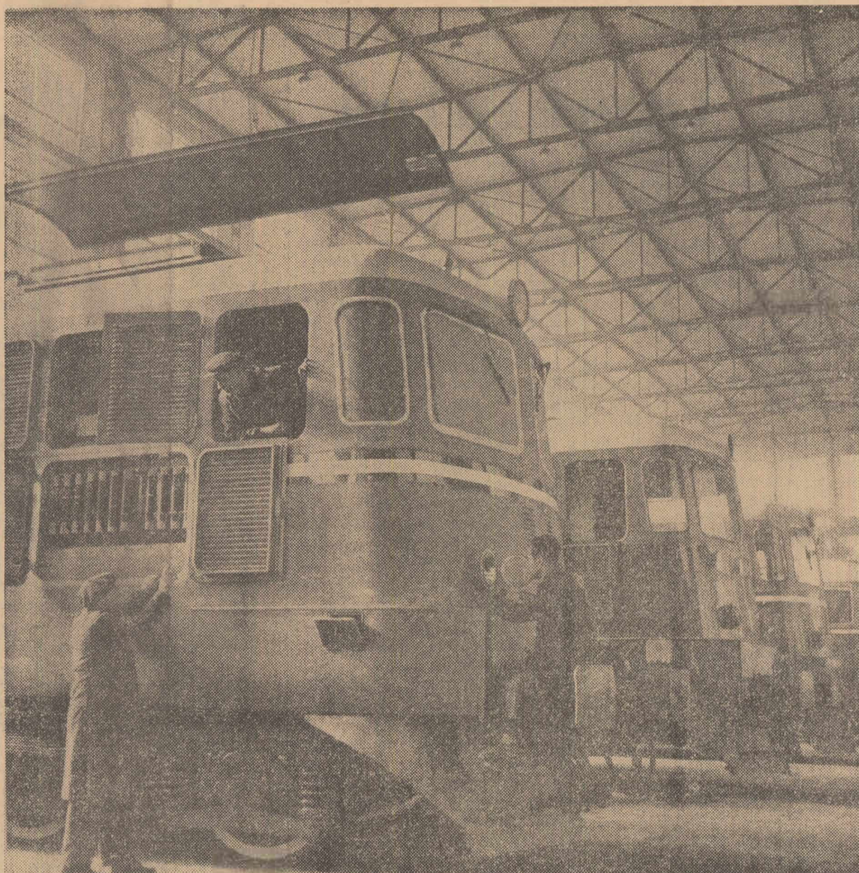
La uzina „Electroputere” din Craiova este pe cale de a se termina construcția celei de-a 100-a locomotivă „Diesel”-electrice. În cliseu: aspect din Hala de montaj a Fabricii de locomotive „Diesel”, din cadrul uzinei „Electroputere” Craiova
