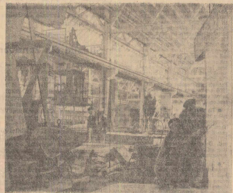
Aspect din secția de fabricare a panourilor din beton a Întreprinderii de prefabricate „Progresul” din Capitală Foto: AGERPRES
