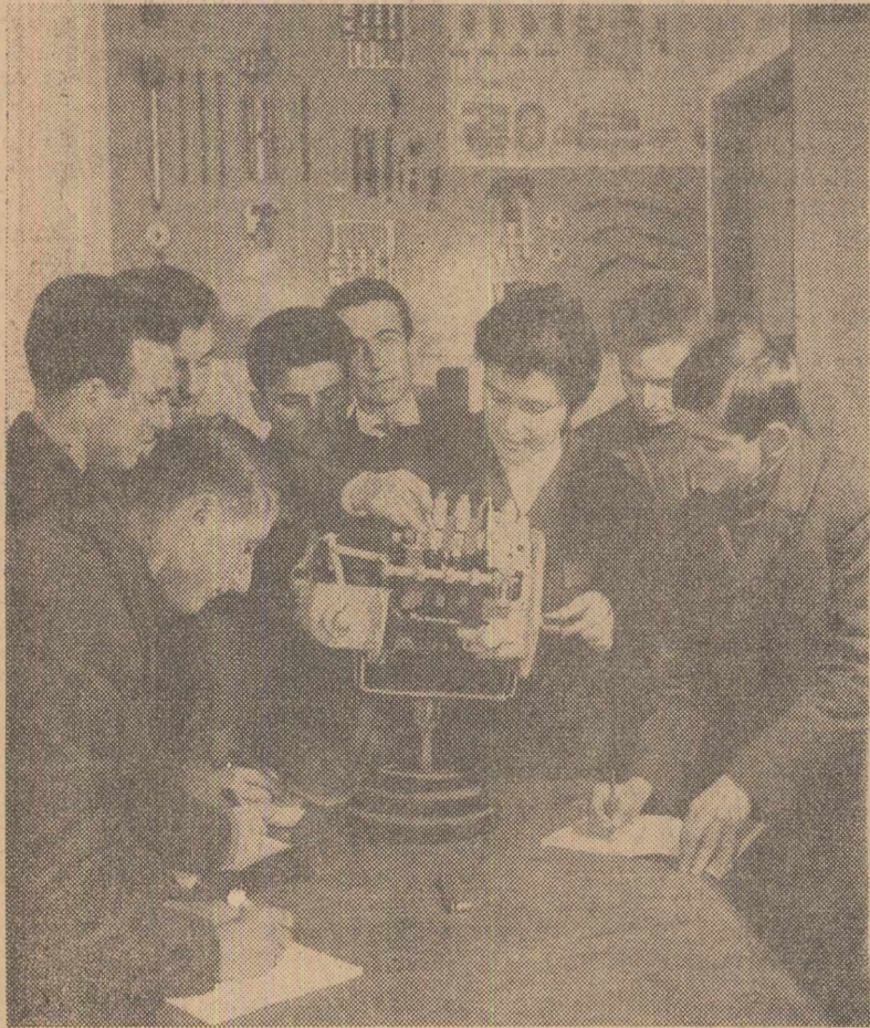
Scoala profesională de mecanici agricoli din Balș, regiunea Oltenia, este frecventată de peste 700 de elevi. În clipă: ingineră Gabriela Diaconescu explică elevilor funcționarea pompei de injecție la tractoare. Foto: AGERPRES
