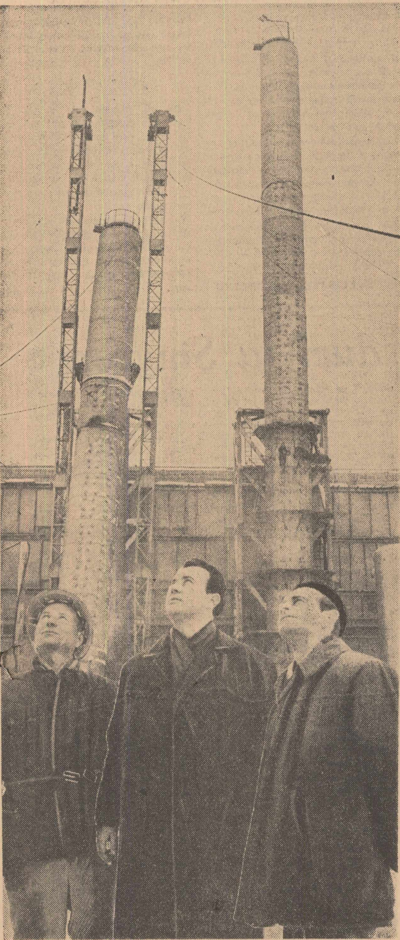
O imagine de pe șantierul Combinatului de îngrășăminte azotoase de la Tg. Mureș. În fața coloanelor de absorbție în curs de montaj, șeful de echipă Nicolae Petcu, ing. Alexandru Cornoșiu, șeful șantierului de montaj, și ing. Ștefan Ordenlich, șef de lot
