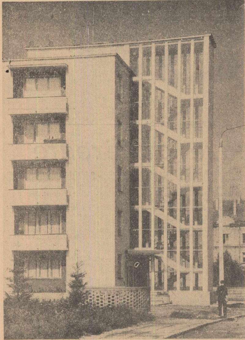
Cartierul Tractorul din Brașov s-a înnoit în ultimii ani cu multe blocuri moderne de locuințe. Iată fațada unuia din blocurile construite în acest cartier
