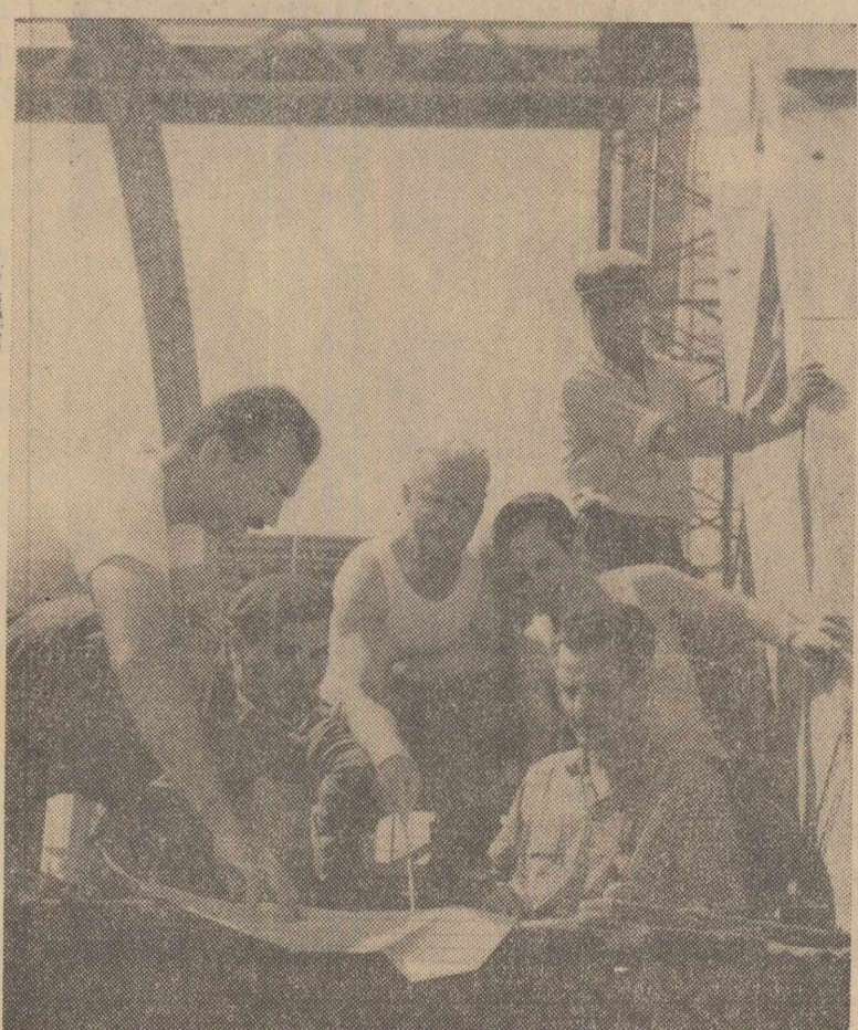
Măgurele: În depozitul de pirită al fabricii de acid sulfuric, fabrică ale cărei lucrări de construcții-montaj s-au încheiat recent, materia primă este pregătită pentru cupatoare cu ajutorul autoincercătoarelor (clicșul din stînga); Pe șantierul sectorului îngrășăminte complexe, un grup de constructori analizează posibilitățile de sporire a ritmului lucrărilor. Recunoaștem în imagine pe ing. Dem. Rădulescu, șeful de lot, pe maestrul Gh. Stamate, pe șefii de echipă Marin Vișescu și Florea Niculescu, pe macaragiul Vasile Ivan și pe montorul Constantin Miron (clicșul din dreapta).
