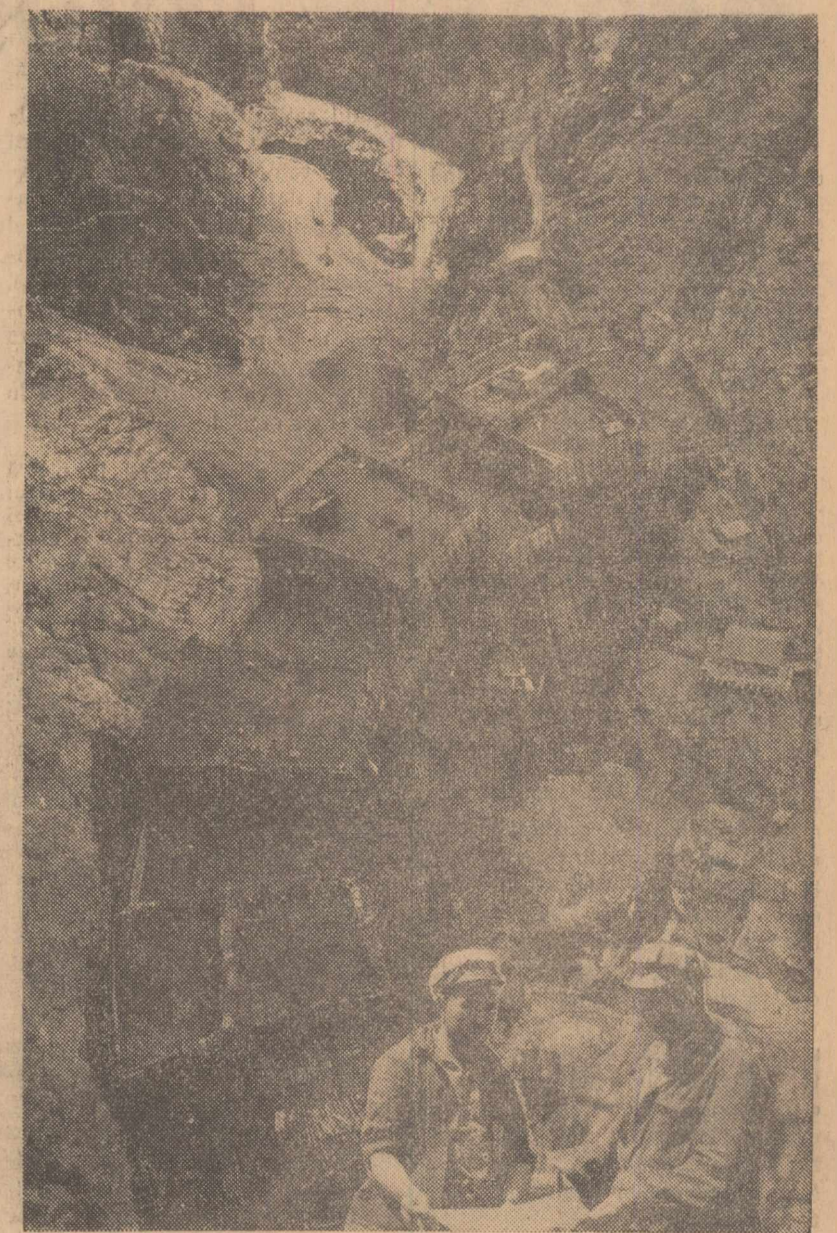
Aspect de la barajul hidrocentral „16 Februarie”
