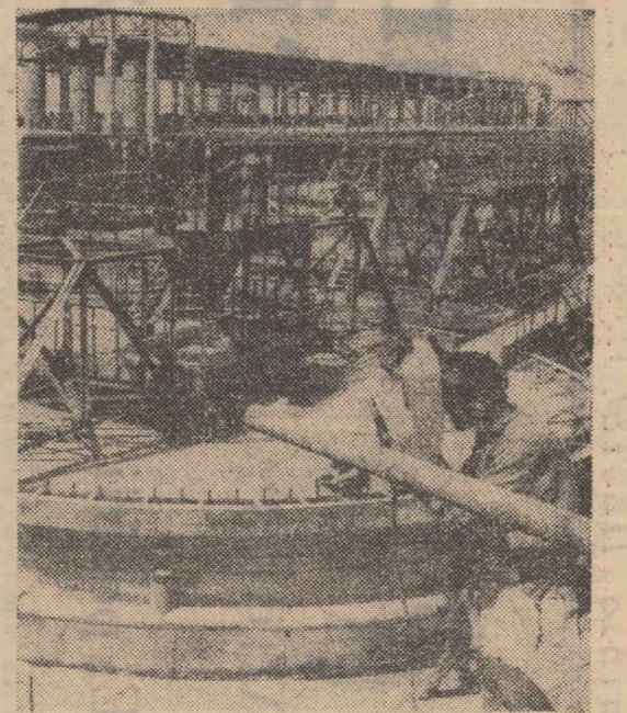
Pe șantierul Uzinei de alumina din Oradea
