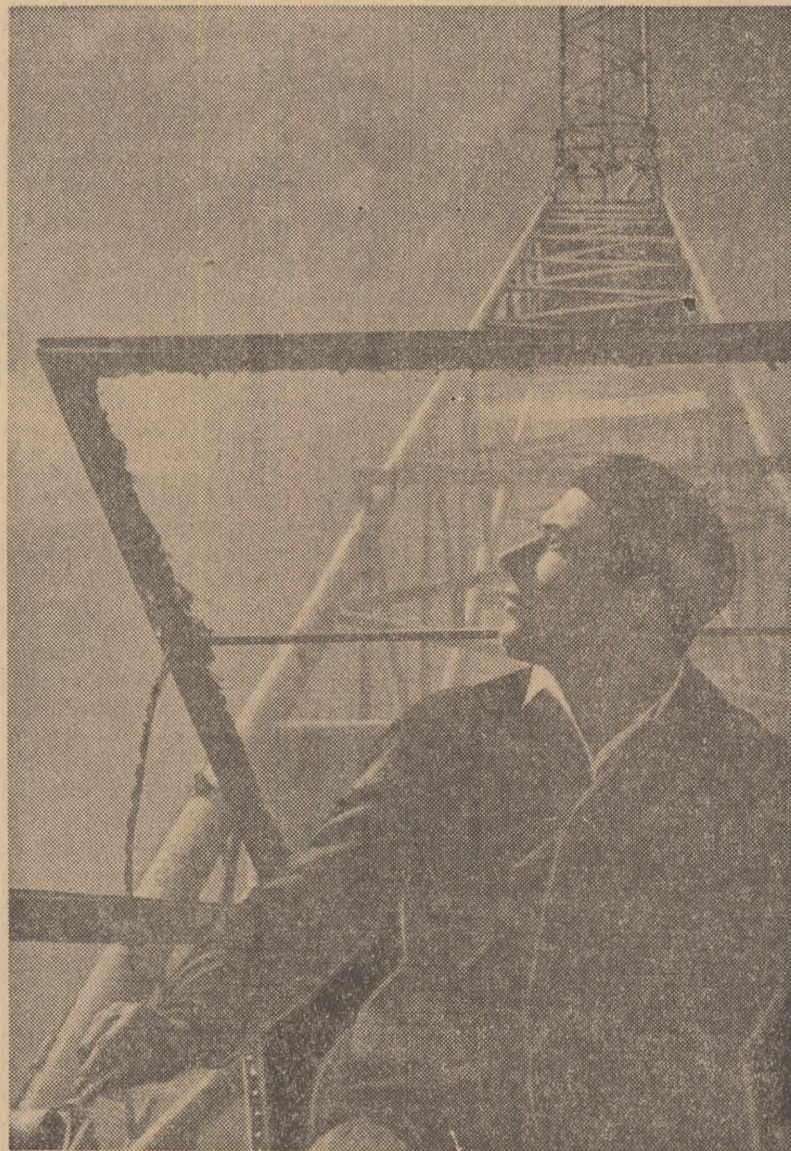
Pentru economisirea de timp și manoperă la ridicarea blocurilor de locuințe în orașul Vulcan, din Valea Jiului, se aplică cu succes metoda cofrajelor gisante. În clișeu: Una din puternicele macarale folosite la gisarea blocurilor cu 9 etaje.
