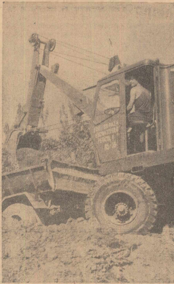
Excavatorul deschide drum nou către un mănunchi de blocuri abia ridicate de constructorii de la I.C.M.2
