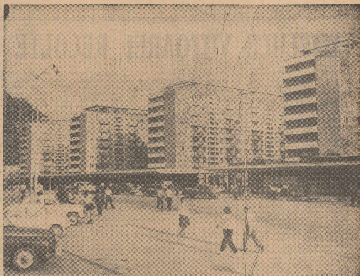
Construcții de noi blocuri în ansamblul care formează centrul orașului Piatra Neamț.
