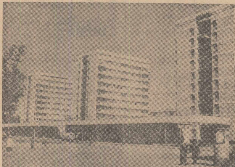
Blocuri noi în Piața gării din Bacău
