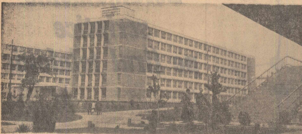
Aspect parțial al complexului studențesc de la Grozăvești
