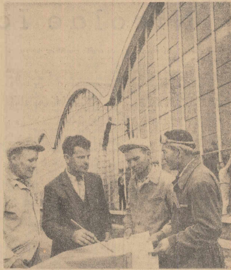
La Combinatul de cauciu Jilava din București se execută în pre-zenț lucrări de construcții — hale noi, extinderea celor vechi — care vor duce la o importantă creștere a capacităților de produc-ție. În cliseu: (de la stînga la dreapta) I. Csaky, Ion Roman, I. Cos-tache și Dumitru Dinescu, constructori fruntași ai șantierului
