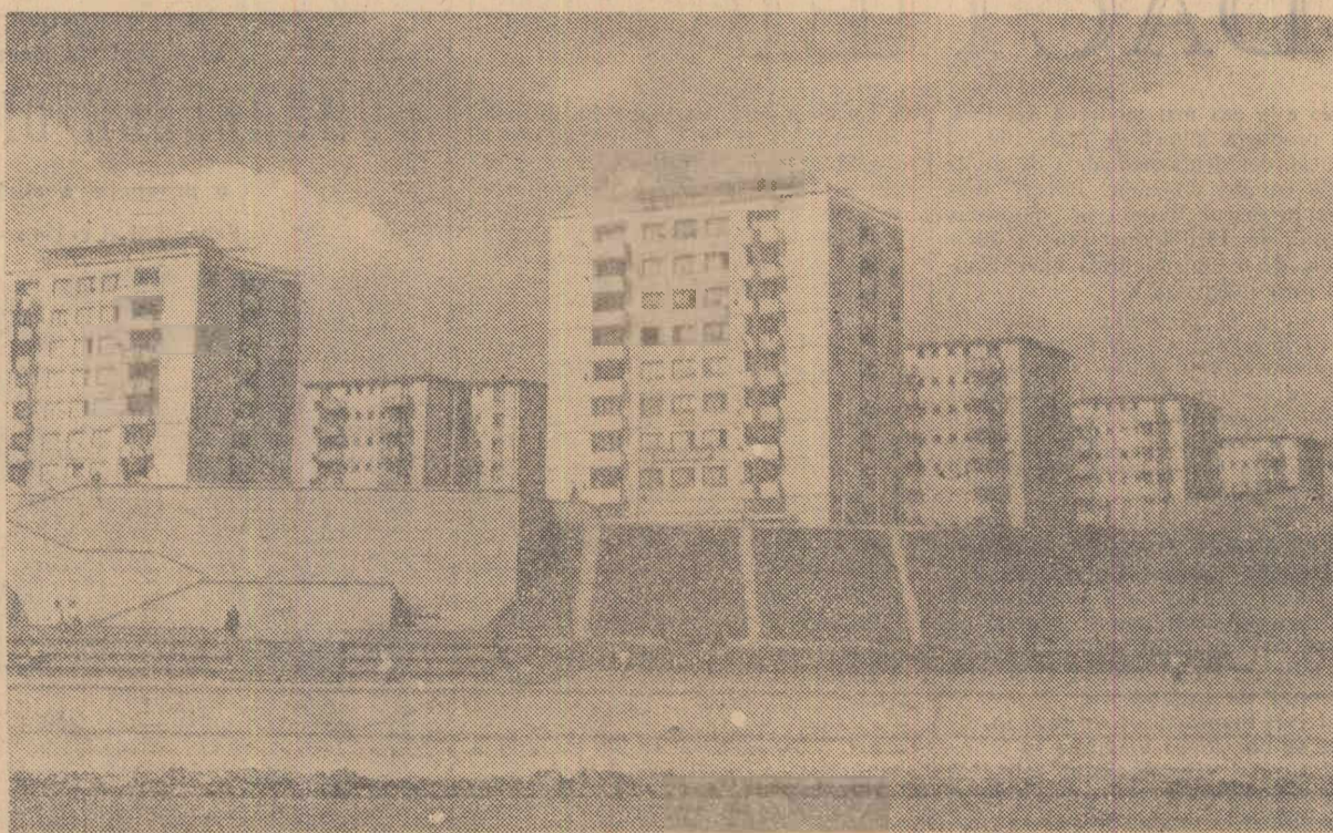
Blocuri noi pe bl. Republicii din Galați (vedere de pe Dunăre)
