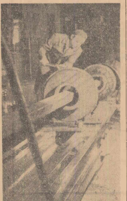
Printre fruntașii Uniunii de țevi din Roman se numără și strungarul Ion Tiu pe care îl vedem în clipșul de mai sus, lucrînd la mașina de găuri-re a prăjilor pătrate pentru foraj.
