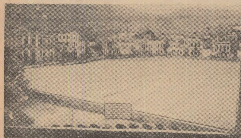
Un aspect al primei uzine grecești de transformare a apelor de mare în apă potabilă. Această uzină, care desalinizează apa prin procedeul distilării cu ajutorul energiei solare, a fost construită în mijlocul insulei Symi (Dodecanez). În timpul zilelor de vară, cînd temperatura solară e mai ridicată, instalațiile uzinei produc 35—40 metri cubi de apă potabilă la 24 ore.
