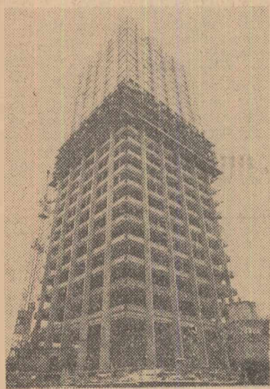
La Winterthur, lângă Zürich va fi, în curînd, terminată construcția celei mai înalte clădiri din Elveția. Lucrările de construcție se află deja în faza finală, după cum se poate vedea și în fotografia de mai sus
