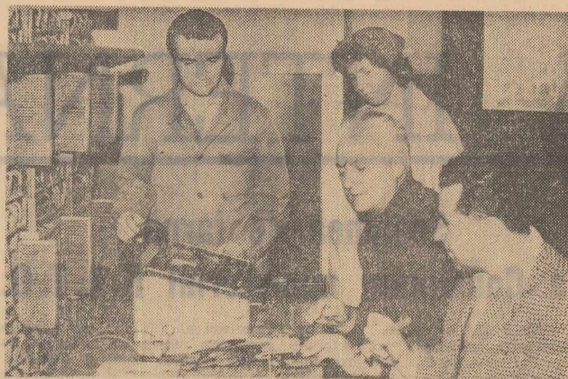
Centra: telefonica automată din Brașov. Electromecanicii C. Păun, Gh. Anuța și H. Roth, ascultă cu atenție explicațiile date de Victor Zalog, șeful centralei. Tema discuției se referă la reglarea electrică a releelor cu un nou aparat de verificare.
