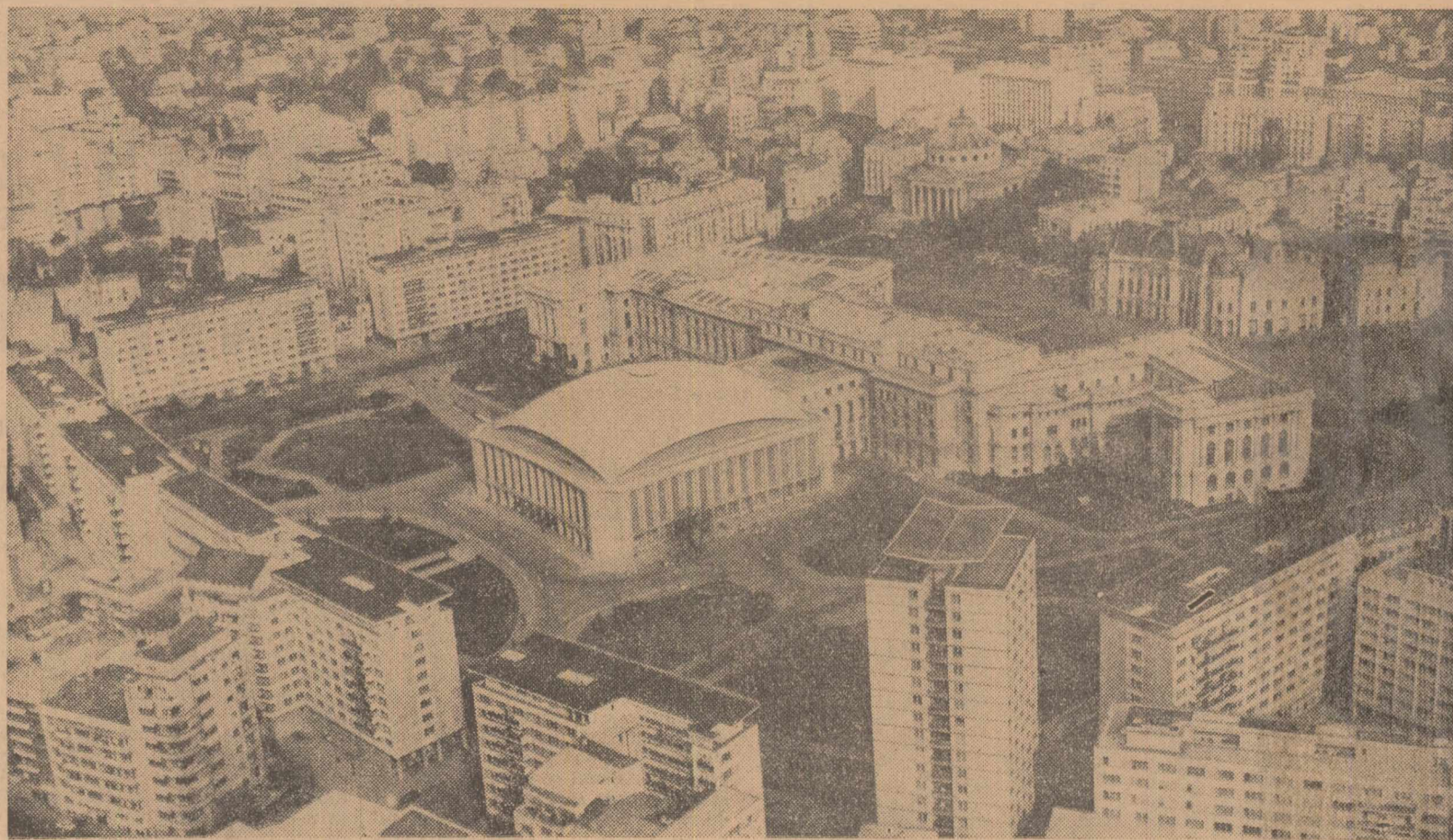
Privită din avion, Piața Palatului R.P.R., această podoabă arhitectonică a centrului capitalei, apare și mai impresionantă. Cu fiecare an ce trece însă, acest grup arhitectural capătă „conurenți” tot mai de seamă în noile cartiere care înfrumusețează necontenit peisajul bucureștean.
