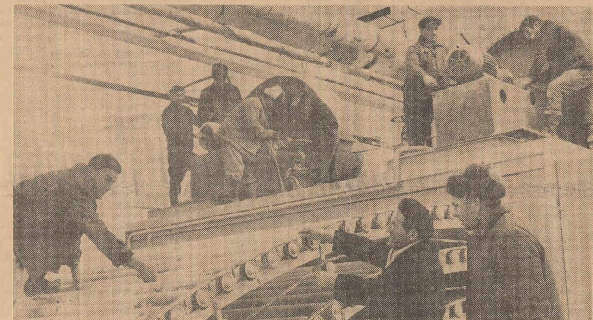
La Turnu Severin se află în construcție un mare complex de industrializare a lemnului. În cliseu: aspect de la montarea utilajului la fabrica de furnire
