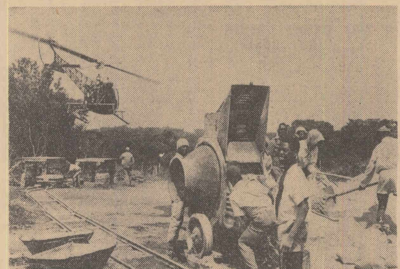
Construcția unei căi ferate înguste printr-o pădure în apropiere de Bacouba, Gabon. Pe această cale vor fi transportate minereurile de mangan de la locurile de extracție pînă la o linie ferată principală.
