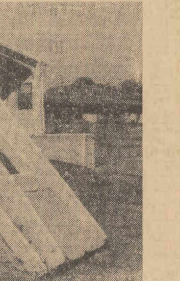
Construcții pentru organizarea de șantier executate la Uzina de fibre sintetice din Iași. În prim plan, un element prefabricat din beton granulat, din care se montează astfel de construcții.
