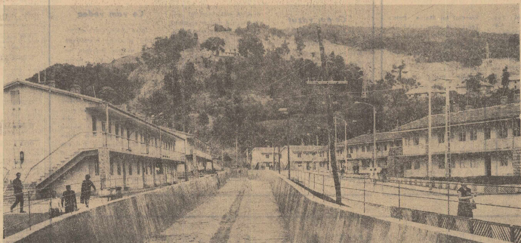
Pe acest fir al apelor Jidoștiei, de o parte și de alta se întinde orașul constructorilor de pe șantierul Baraj-Uzină al Sistemului hidroenergetic și de navigație Porțile de Fier. Acesta oferă cele mai bune condiții de locuit, avînd și un puternic grup social-cultural. Foto: M. POPESCU
