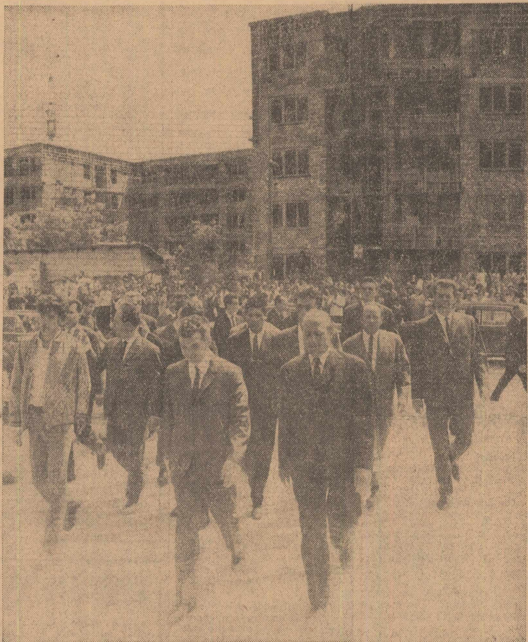
Vizitând noile construcții din Slobozia
